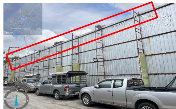
รูปที่ ก-14 ม่านละอองน้ำบริเวณรั้ว Metal Sheet รอบโครงการ
