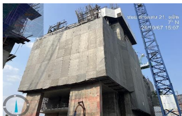
รูปที่ ก-9 ติดตั้ง Mesh Sheet ปิดคลุมรอบตัวอาคาร
