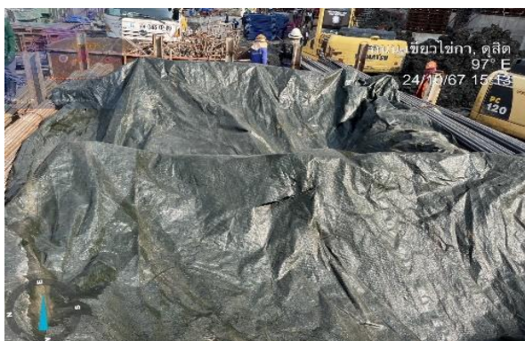
รูปที่ ก-4 การปิดคลุมวัสดุก่อสร้าง การเก็บในพื้นที่ปิดล้อม
